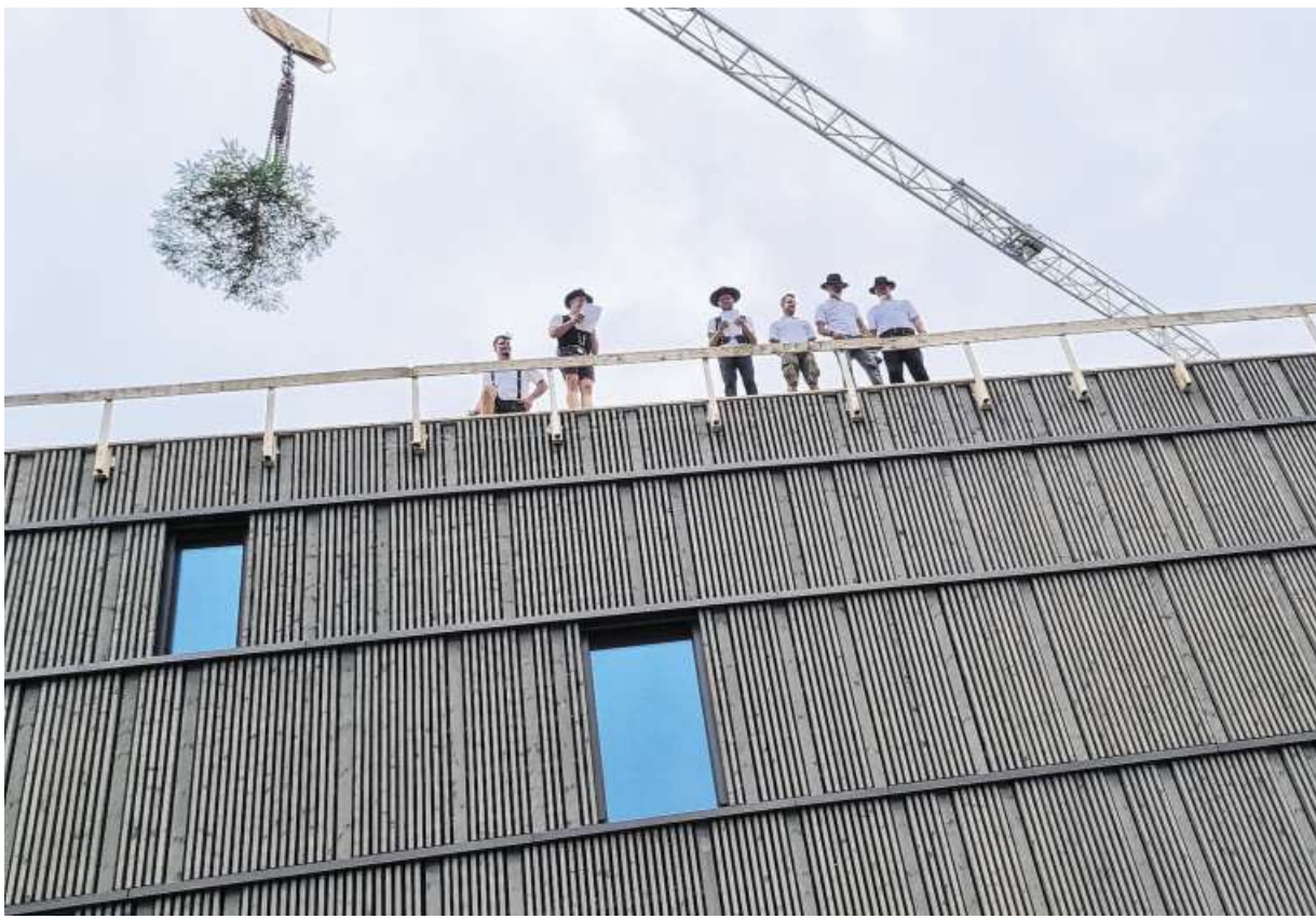
Richtfest für die neue Produktionshalle der Schmid GmbH in Simmerberg: Den Richtspruch am Freitag sprachen Florian Dauer (zweiter von links) und Tobias Pletschacher (rechts daneben) von der Firma Pletschacher in Dasing.
